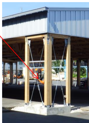
ターンバックルブレース
