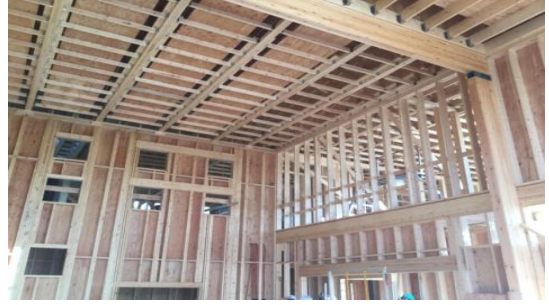
埼玉県：保育園（2×4工法）
