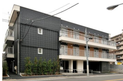
東京都台東区：グループホーム（軸組工法）
