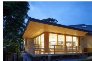
埼玉県：認定こども園（軸組工法）
