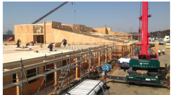
千葉県：特別養護老人ホーム2×4工法）
