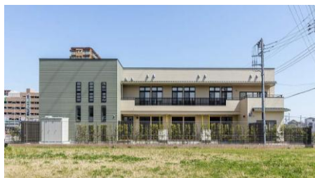
埼玉県：保育園（2×4工法）
